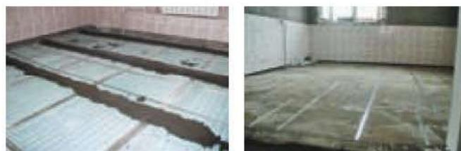
3. Разложить нагревательный кабель и закрепить на ленте с соблюдением шага укладки. Также на ленте закрепить датчик температуры пола в медной или гофрированной трубке (гофр – защита от сдавливания при заливке раствором) и подвести «холодные» выводы нагревательного кабеля и выводы датчика к месту установки терморегулятора.
