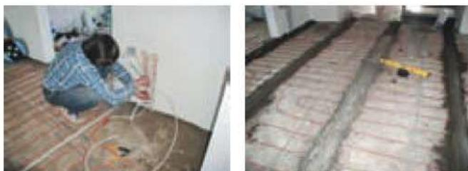
Трубка термодатчика ( $\varnothing$  9 - 16 мм) должна быть заглушена со стороны датчика для предотвращения попадания внутрь раствора при заливке стяжки. Противоположный конец трубки выводят в монтажную коробку, в которой затем будет смонтирован терморегулятор. Чтобы обеспечить свободное перемещение термодатчика в трубке (возможность замены в процессе эксплуатации), рекомендуем при переходе от стены к полу выполнять два больших радиуса изгиба трубки в двух плоскостях.
