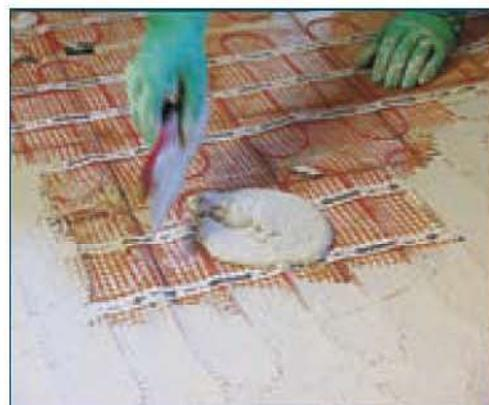
После высыхания клея (см. рекомендации производителя) необходимо установить терморегулятор и произвести необходимые электрические соединения.
