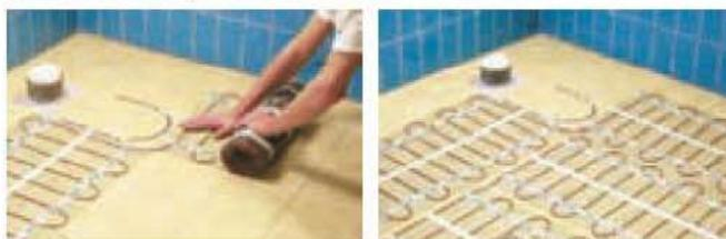
На разложенный мат **DEVI** наносят плиточный клей (плиточную мастику) и укладывают плитку.
