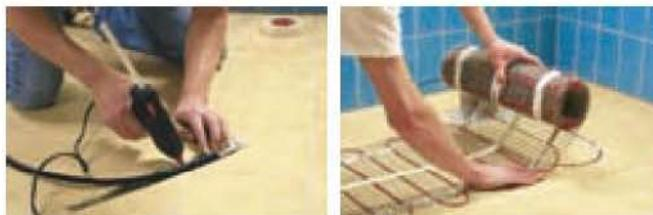
У противоположной стены или при обходе места установки стационарного оборудования сетку мата разрезают и мат поворачивают вокруг кабеля в нужном направлении.
