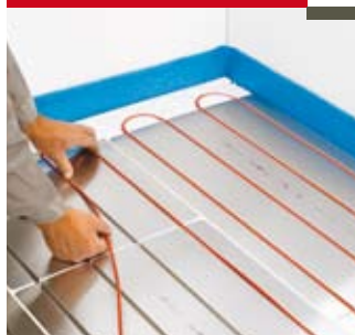
Укладка греющего кабеля
