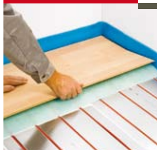
Укладка деревянного пола
