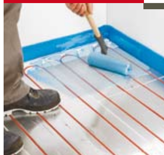
Нанесите грунтовку роликом
