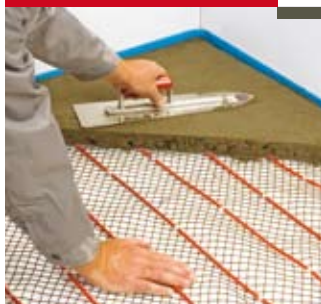
Нанесение стяжки
