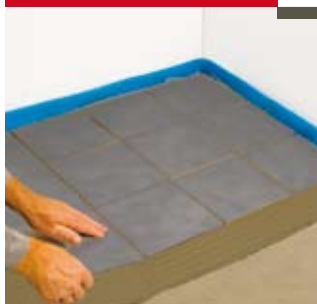
Укладка керамической плитки
