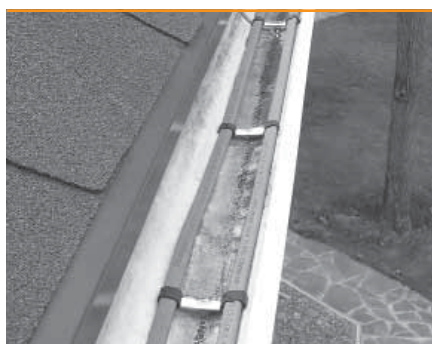
6 водосборные лотки (водосборные желоба)
