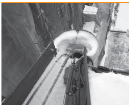
1 водометы и водометные окна в парапетах
